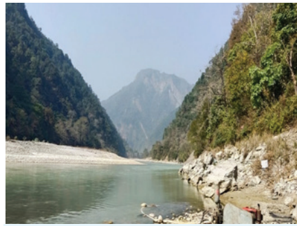
Lower Seti Barrage Site
